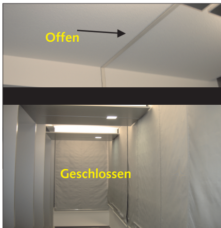
Rauchschtzvordänge in einem Treppenhaus
