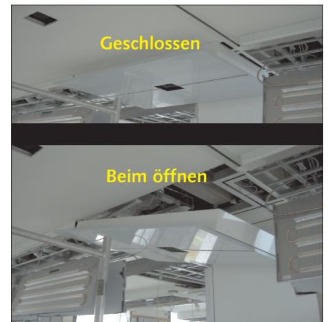
RWA als Dachausstieg mit Zwischendecke
