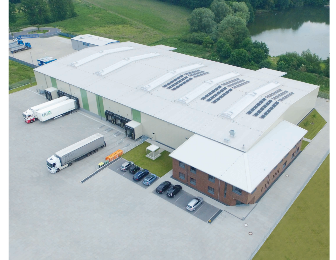
Hallenbau: EP Logistik in Ovelgönne
