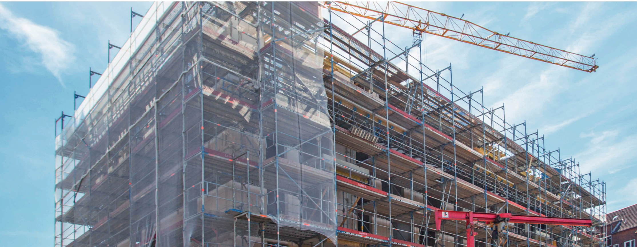
Wohnungsbau: Stahlthiete, Hamburg
