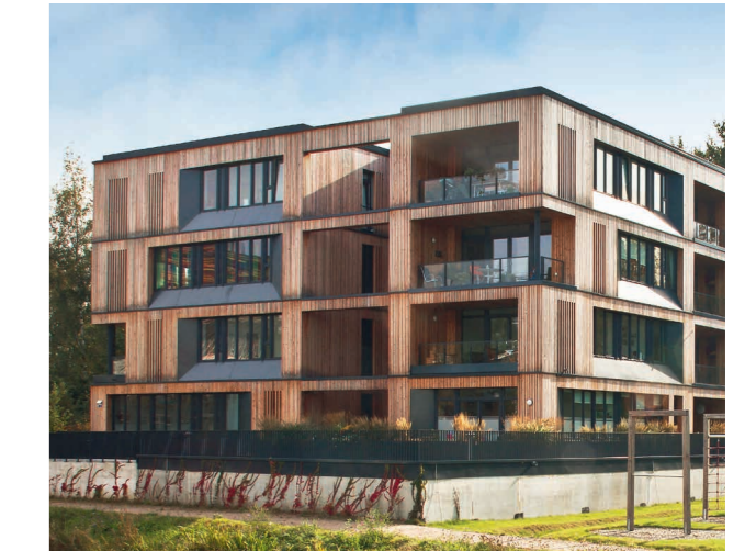
Rohbau für nachhaltige Effizienz: Hybrid-House Hamburg
