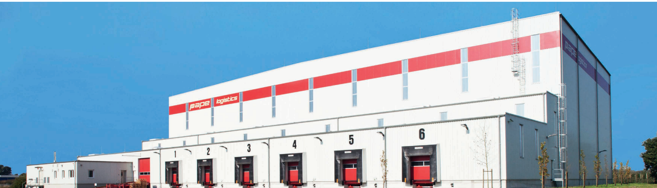
Hallenbau: Pape Logistics in Stade
