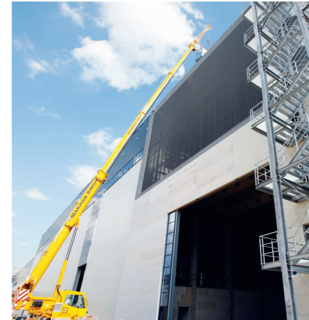
Hallenbau: Airbus-Hallen 60 und 80 in Stade
