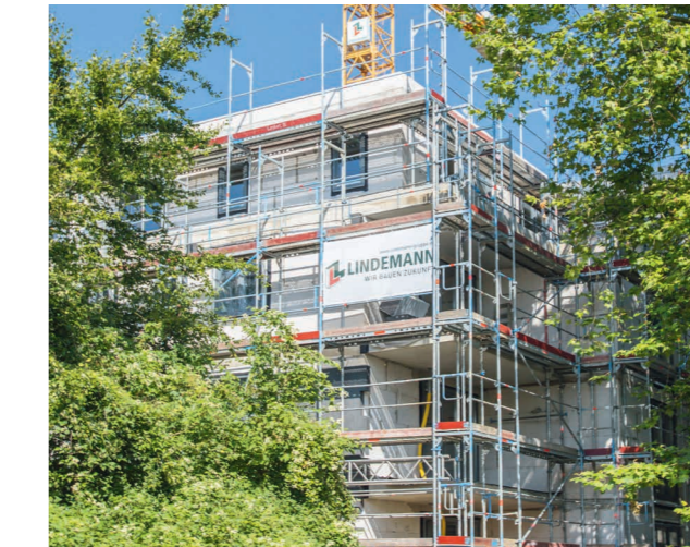
Rohbau für wirtschaftlichen Energieverbrauch
