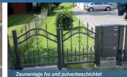
Zaunanlage fvz und pulverbeschichtet
