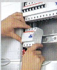
Im Alltag kann allzu schnell etwas passieren. Ein Kind, das mit einem Nagel die Steckdose untersucht oder ein blank gescheuertes Kabel. All dies kann schwerste Verletzungen hervorrufen. Deshalb sind Fehlerstrom-Schutzschalter so wichtig.
