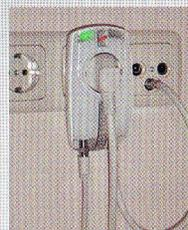
Der erste Schritt ist der Einbau von Überspannungsschutzgeräten im Wohnungsverteiler und an Telefon-, Internet- und Kabelfernseh-Anschlüssen.
