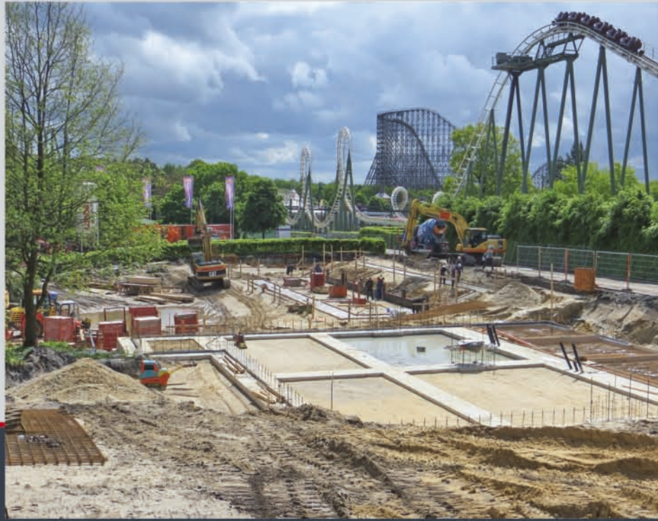
Gründung für den Neubau einer Achterbahn im Heidepark Soltau
