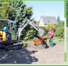
Moderner Minibagger und Elektro-Schubkarre im Einsatz
