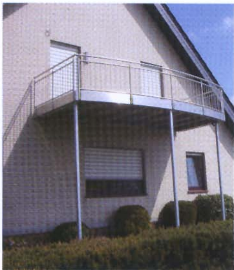
Balkon verzinkt als Stahlkonstruktion
