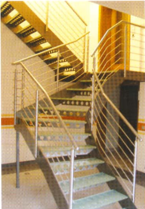
Innentreppe mit Glasstufen
