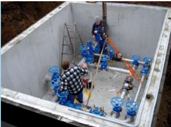
05 | Trinkwasserschächte komplett installiert
