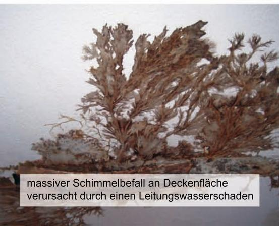
massiver Schimmelbefall an Deckenfläche verursacht durch einen Leitungswasserschaden
