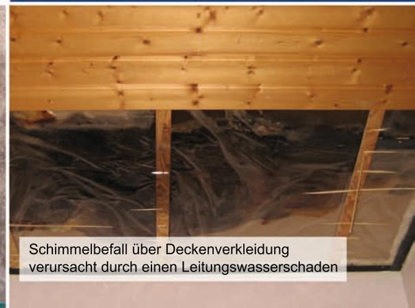
Schimmelbefall über Deckenverkleidung verursacht durch einen Leitungswasserschaden
