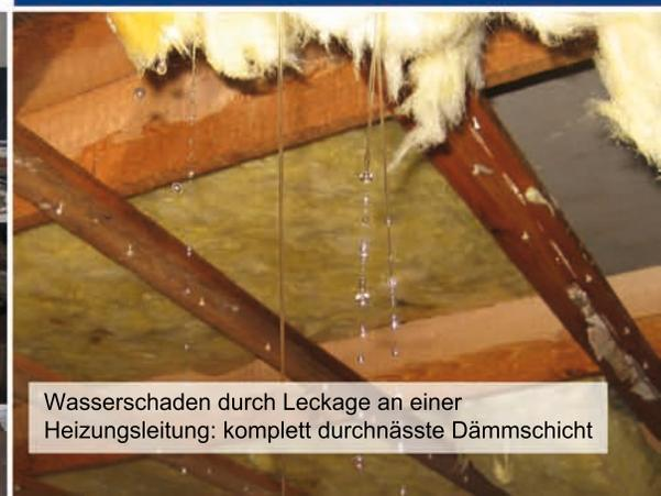
Wasserschaden durch Leckage an einer Heizungsleitung: komplett durchnässte Dämmschicht
