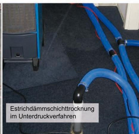
Estrichdämmschichttrocknung im Unterdruckverfahren
