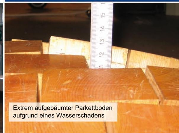
Extrem aufgeblähter Parkettboden aufgrund eines Wasserschadens
