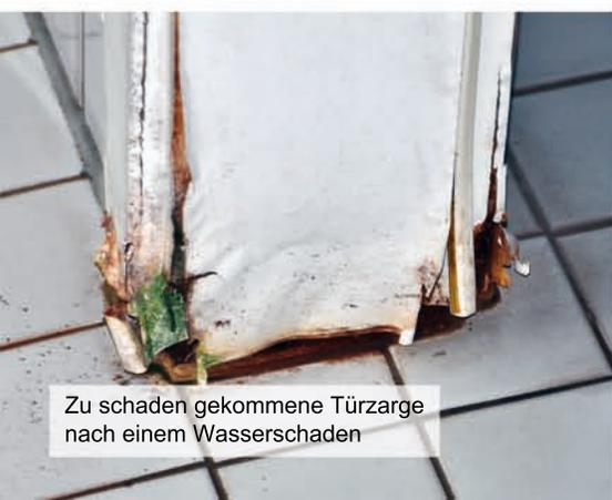
Zu schaden gekommene Türzarge nach einem Wasserschaden
