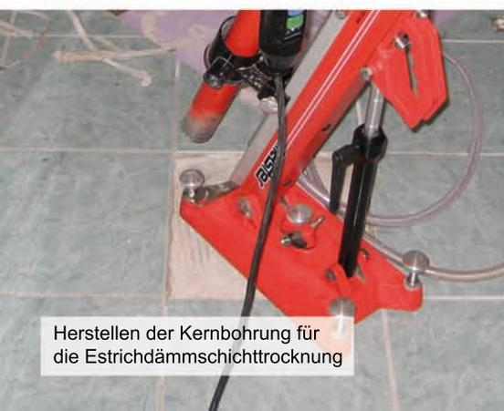
Herstellen der Kernbohrung für die Estrichdämmschichttrocknung
