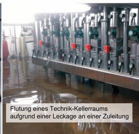
Flutung eines Technik-Kellerraums aufgrund einer Leckage an einer Zuleitung
