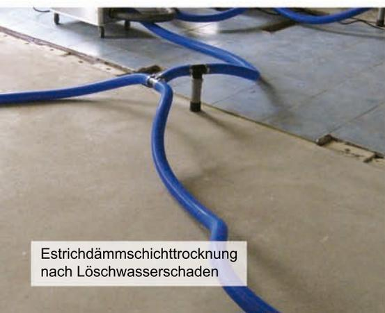
Estrichdämmschichttrocknung nach Löschwasserschaden
